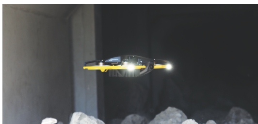
カルバート内部
