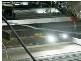
天井裏・地下ピット
