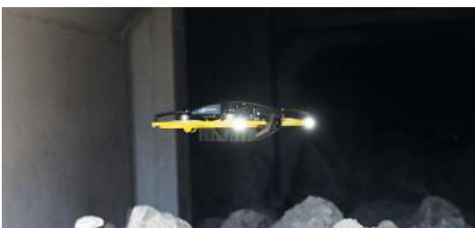
カルバート内部
