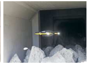
下水道・カルバート内部
