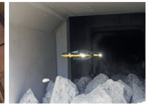
下水道・カルバート内部
