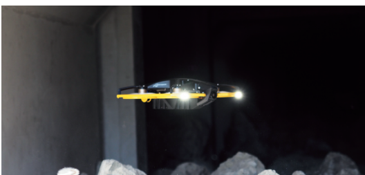
カルバート内部
