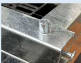
ピンの設置で前後左右のズレ防止
