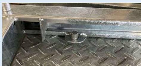
ピンの設置で前後左右のズレ防止
