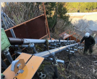
地すべり監視（全景）
