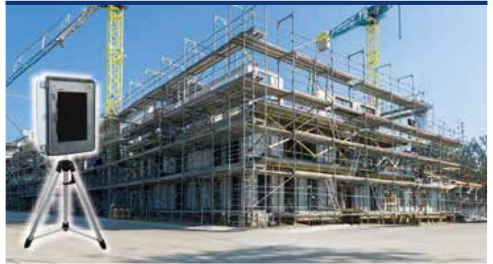
高所作業現場の入り口で
