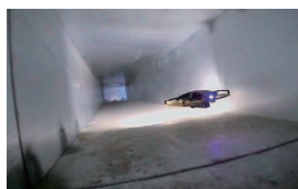
ダクト・配管内部
