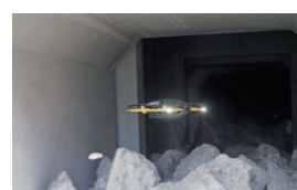
下水道・カルバート内部
