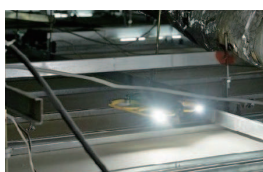
天井裏・地下ピット
