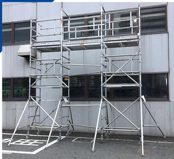
2段2基連結 (アウトリガー8本設置)
