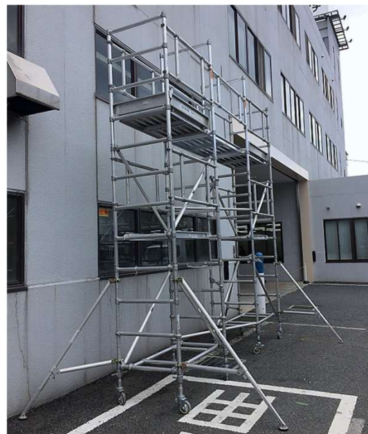
2段2基連結 (アウトリガー4本設置)
